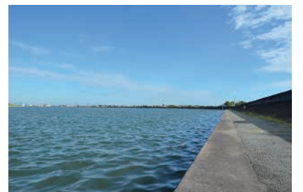
海水と淡水がほどよく混ざる五十鈴川河口近く。 堤防が弧を描くところの杜に御塩浜がある。
